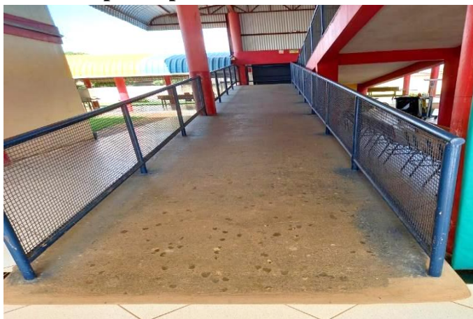
Figura 3 – Rampa de acesso ao piso superior
