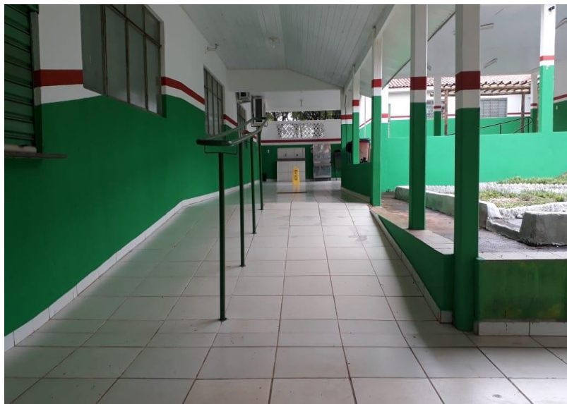
Figura 8 – Fotografia: Rampa de acesso à área de convivência.
