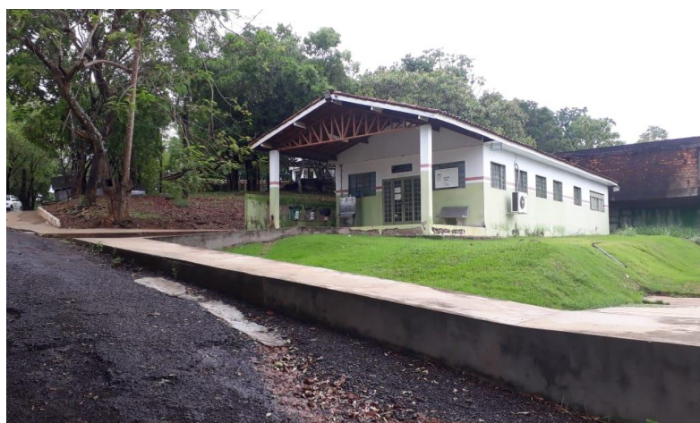
Figura 10 – Fotografia: Acesso à Biblioteca.
