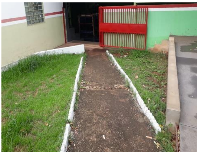
Figura 5 – Fotografia: Rampa de acesso à quadra poliesportiva, do pátio para a quadra.
