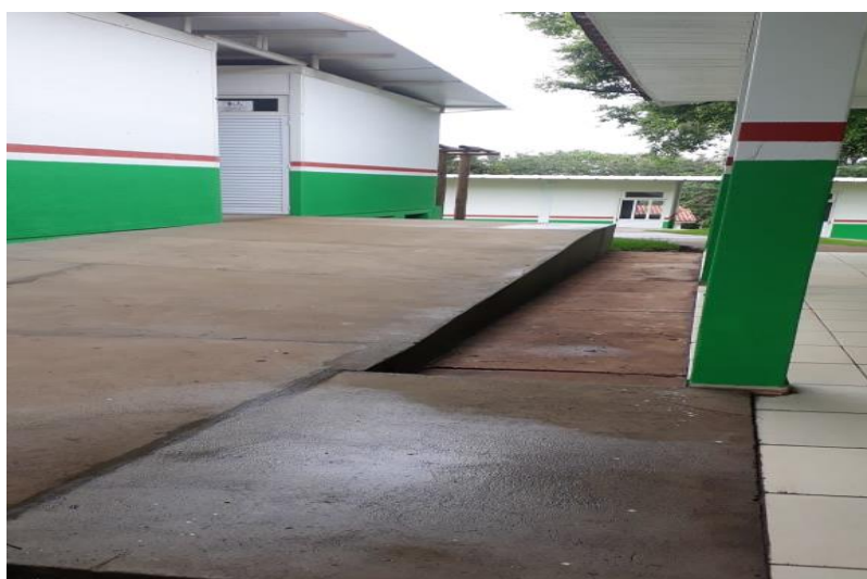
Figura 11 – Fotografia: Rampa de acesso aos banheiros feminino e masculino.
