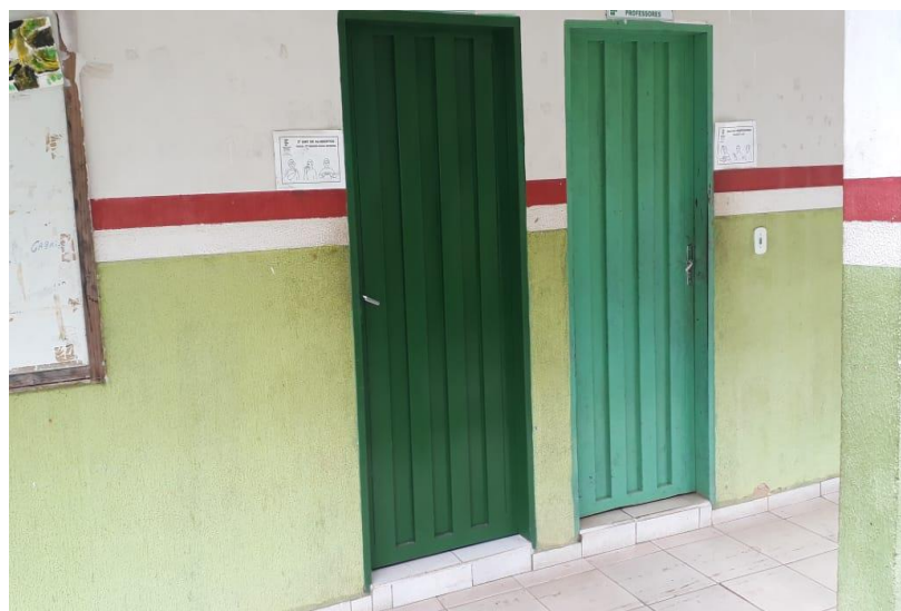
Figura 4 – Fotografia: Sala de aula e sala de professores.
